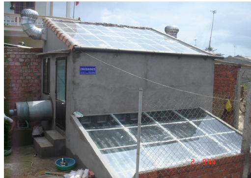
Hình 3. Hệ thống sấy khô SMT-01LS xây dựng tại An Vĩnh, Lý Sơn, Quảng Ngãi
